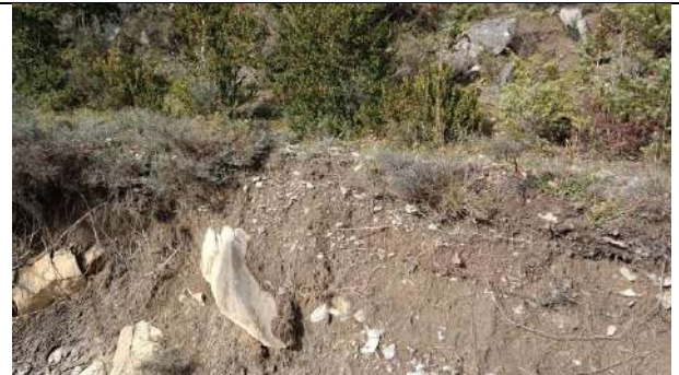
Foto 6: Ruta 30, derrumbe parcial antes de punto 5
