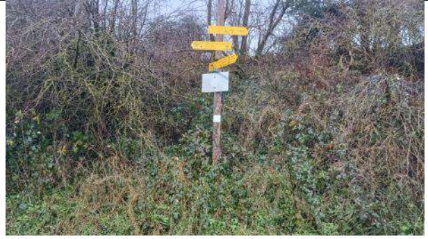
Foto 12: Ruta 29, Punto 4, poste inclinado
