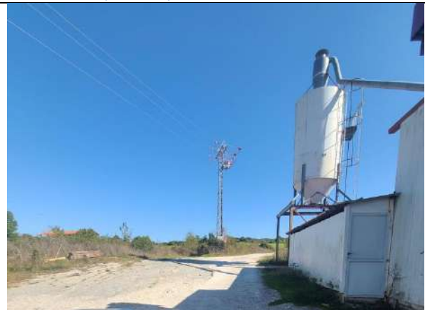
Foto 4: Ruta 7, Punto 4, nueva lama en poste electrico
