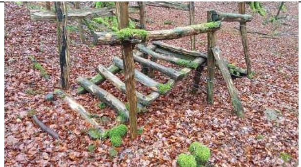
Foto 8: Ruta 29, paso de cierre con rampa de madera
