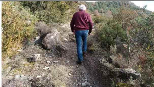
Foto 5: Ruta 30, sendero antes de derrumbe parcial
