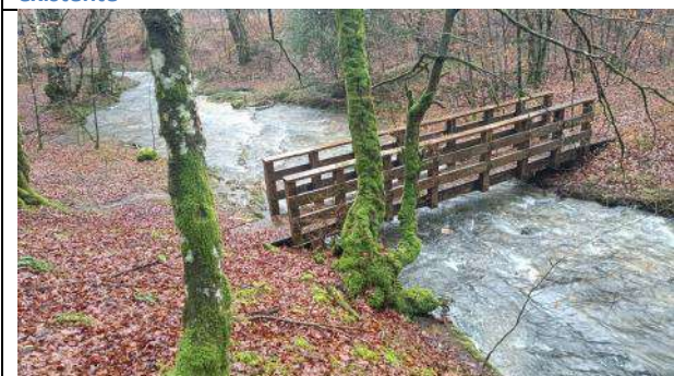
Foto 7: Ruta 29, paso de regata, puente de madera
