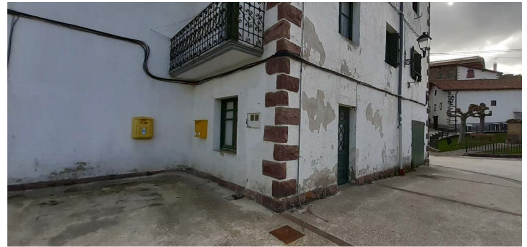
Accesos antes de la reforma
